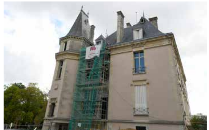
Grâce à cet aménagement, les différents niveaux du Château du Charmois pourront être accessibles à tous
