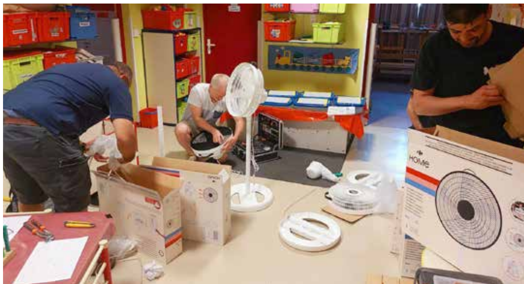
350 ventilateurs et 34 climatiseurs ont été installés dans les écoles durant la canicule
