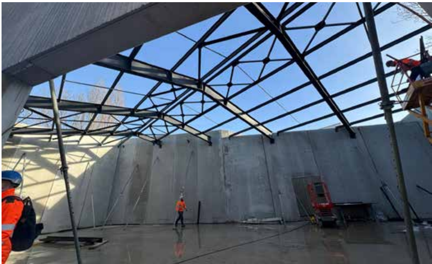
Travaux de construction de l'auditorium de l'école municipale de musique ayant débutés à l'été 2025
