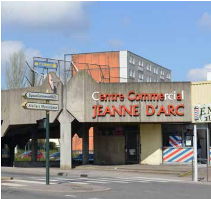
Le centre commercial Jean d'Arc bientôt éboulé
