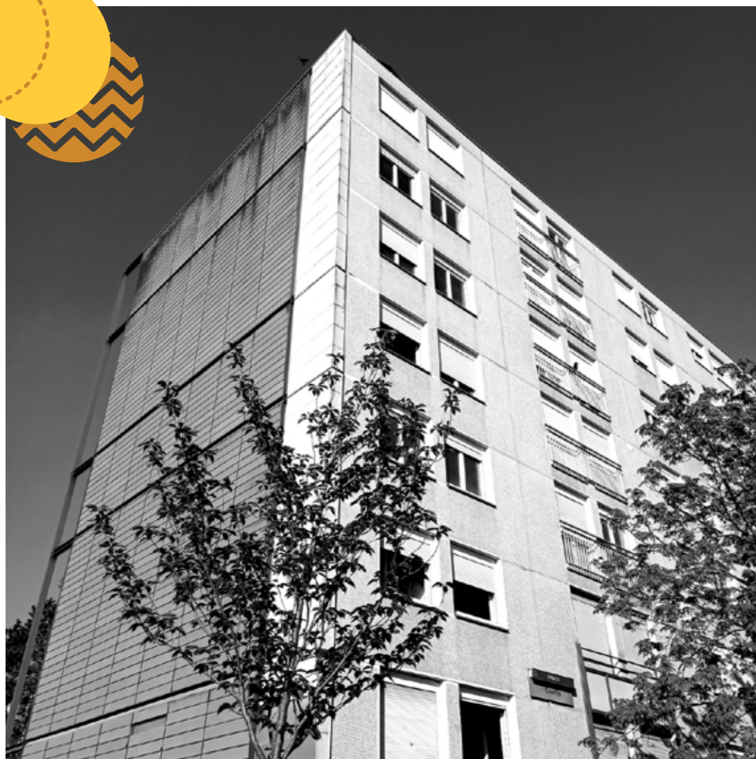
Immeuble Les Courlis, démoli en fin d'année 2024, dans le cadre du NPRU
